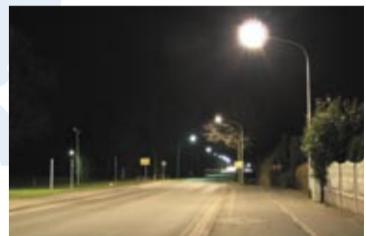
Lohne, Tyskland – foran: 1 x Koffer 2 -armatur med 1 x MASTER CosmoWhite 60 W, bak: 1 x armatur med 2 x HPL 125 W
