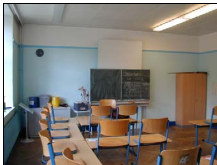
Klassenzimmer mit alter herkömmlicher Technik mit Wannenleuchten ohne Tafelbeleuchtung
